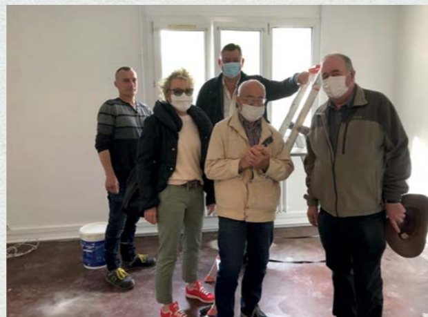
Visite de M. le Maire et de ses adjoints, du chantier rénovation du futur logement aux écoles, destiné au nouveau médecin, réalisé par les services techniques.
