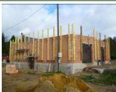
Maison de Santé Les murs sont édifiés
