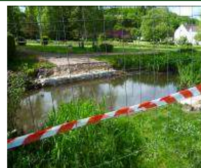
Le Sté Bonin a rénové un pont au plan d'eau
