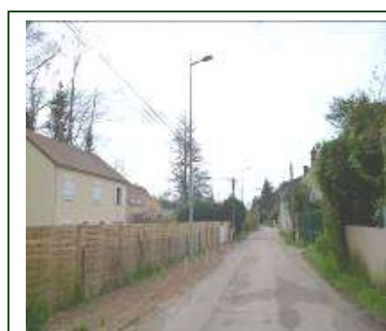
Eclairage public Rue Pasteur
