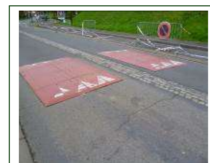
Coussins berlinois : sécurisation du groupe scolaire
