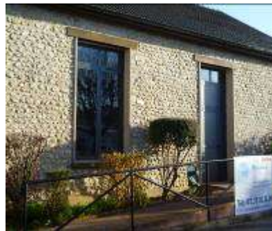
Salle des Fêtes Changement des fenêtres et des
