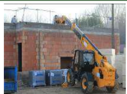
Maison de Santé Les travaux avancent
