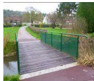
Réfection d'un pont du plan d'eau
