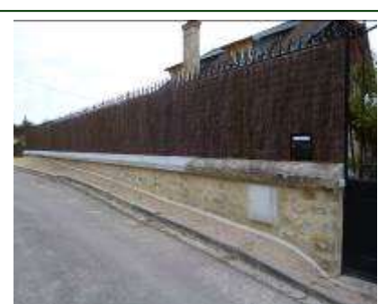
Mur de Soutènement rue de Jubert
