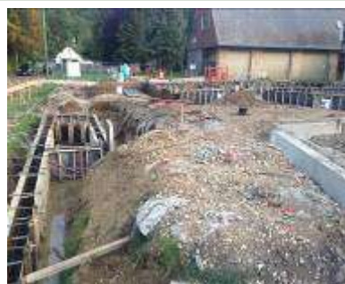
Maison de Santé Début du Chantier
